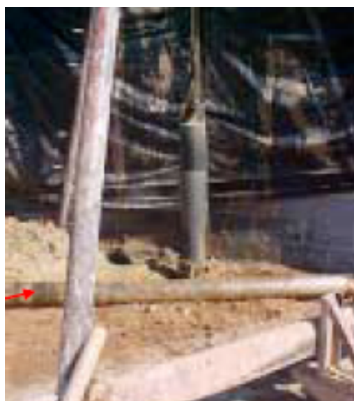
Figura 4.6 – Execução das estacas do tipo Strauss – cravação da piteira
