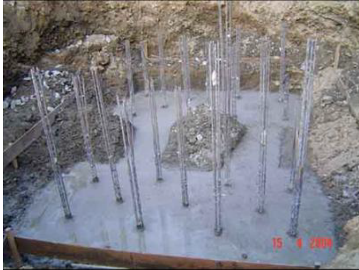
Figura 4.18 – Estaqueamento formado por um grupo de estacas-raiz
