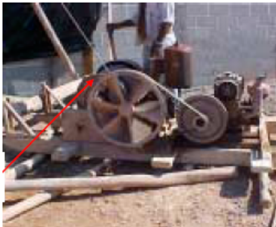
Figura 4.5 – Conjunto mecanizado utilizado na execução das estacas do tipo Strauss
