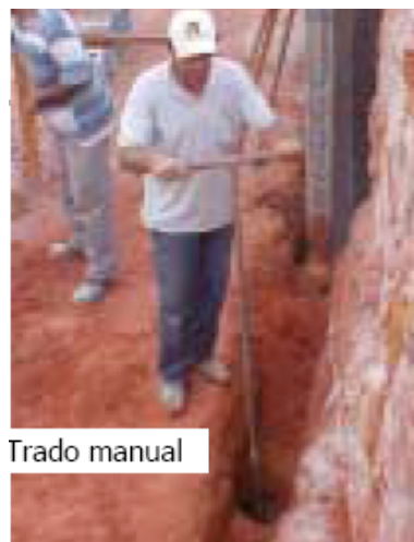
Figura 4.3 – Execução de estaca tipo broca
