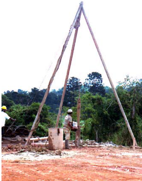
Figura 4.4 – Tripé para execução das estacas do tipo Strauss
