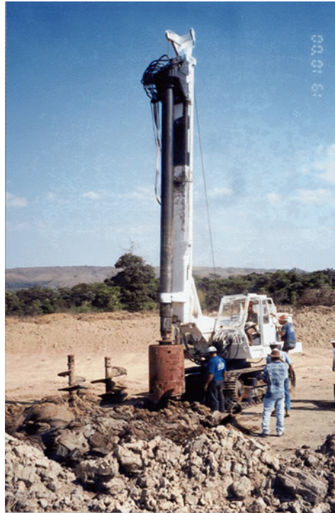
Figura 4.8 – Equipamento para execução das estacas escavadas mecanicamente com trado helicoidal
