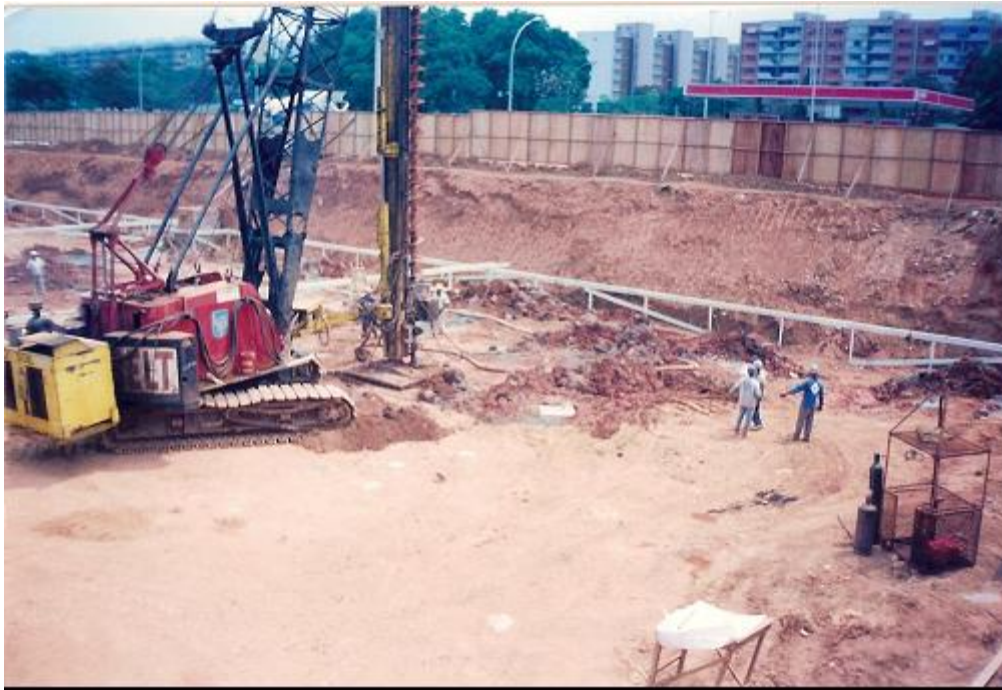
Figura 4.9 – Equipamento para execução das estacas do tipo hélice contínua
