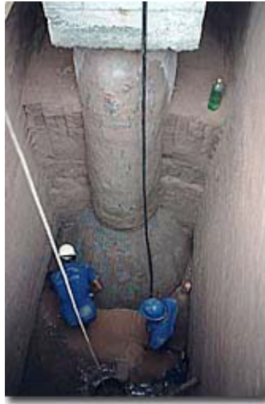
Figura 4.25 – Tubulão a céu aberto com base alargada
