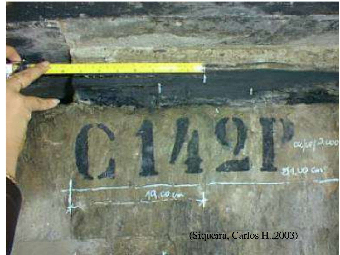
Aparelho de apoio de neoprene- Ponte Rio Niterói
