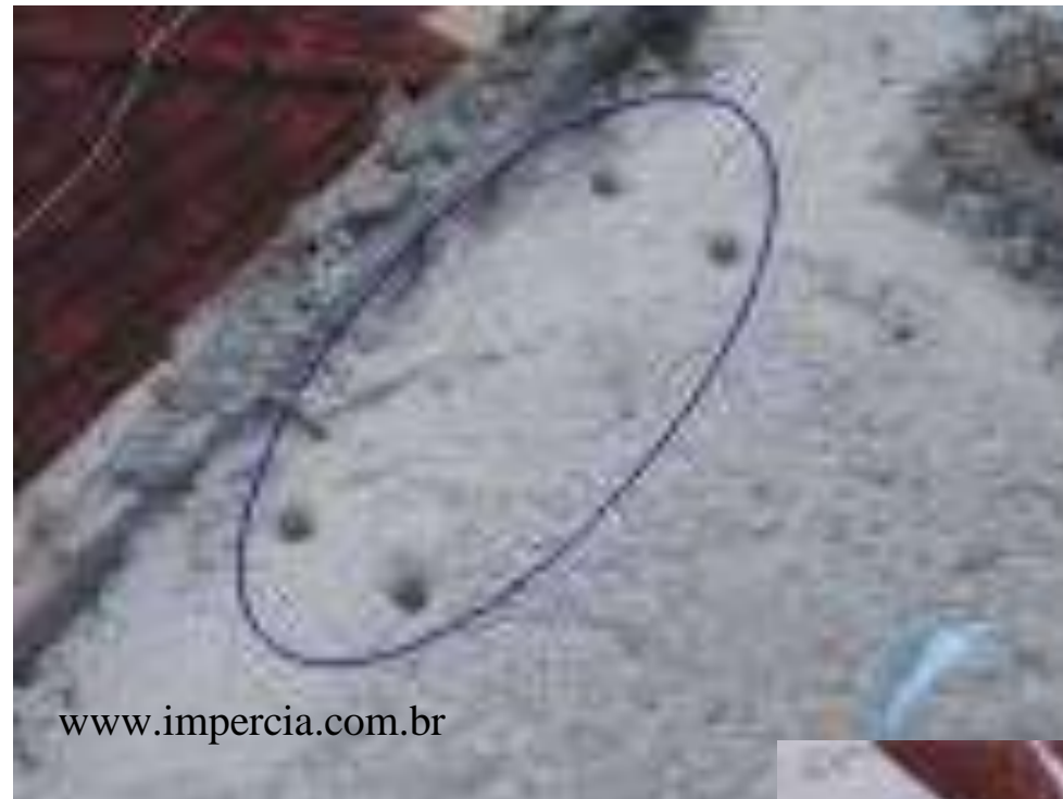
Perfuração da peça de concreto
