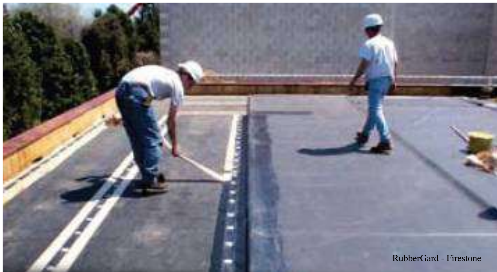
Manta butílica aplicada sobre laje para impermeabilização
