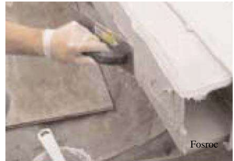
Colagem de peças pré-moldadas com argamassa epóxi tixotrópica
