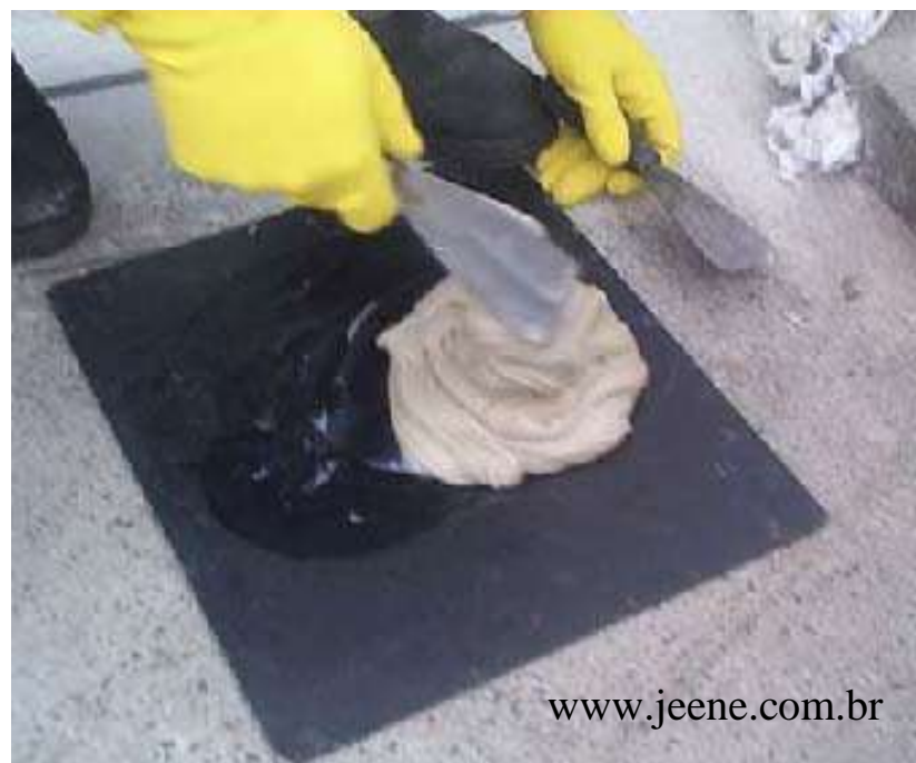
Colagem de peças pré-moldadas com argamassa epóxi tixotrópica
