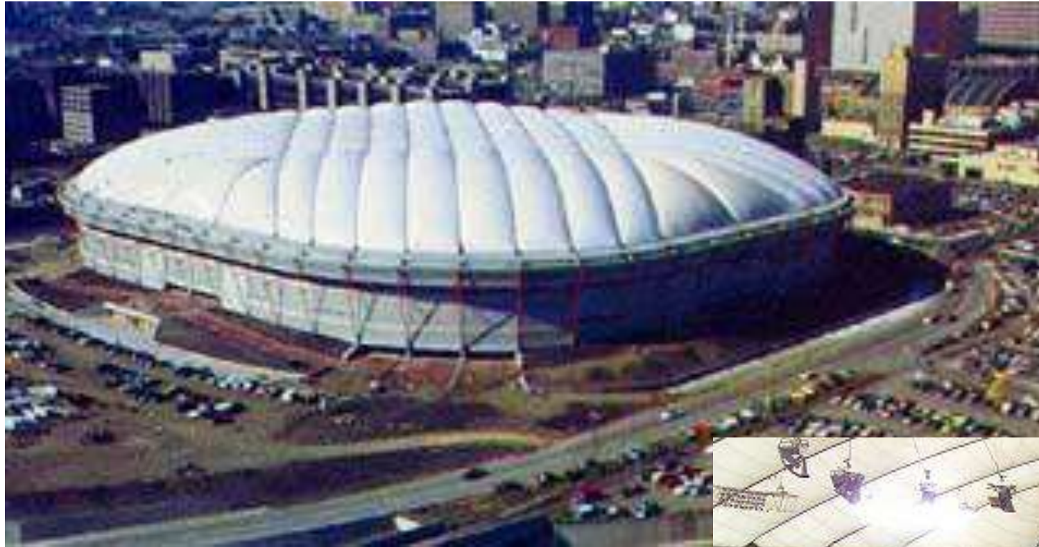
A cobertura do Hubert H. Humphrey Metrodome (Minnessota) feita de fibra-de-vidro revestida de Teflon
