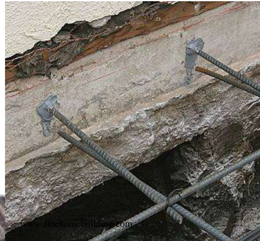
Fixação das armaduras de espera no concreto
